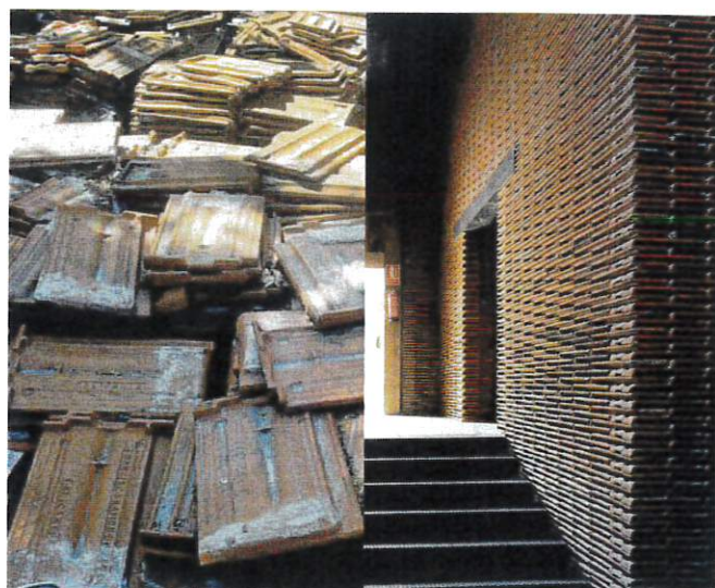
Réutilisation de tuiles plates pour construire les cloisons du nouveau bâtiment
