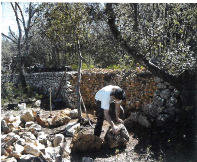
Reconstruction de murs avec les pierres du site
