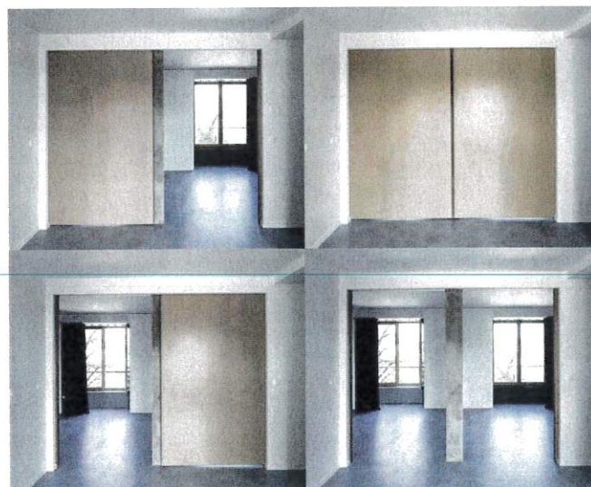
Cloisons mobiles qui permettent de moduler l'espace dans un appartement
