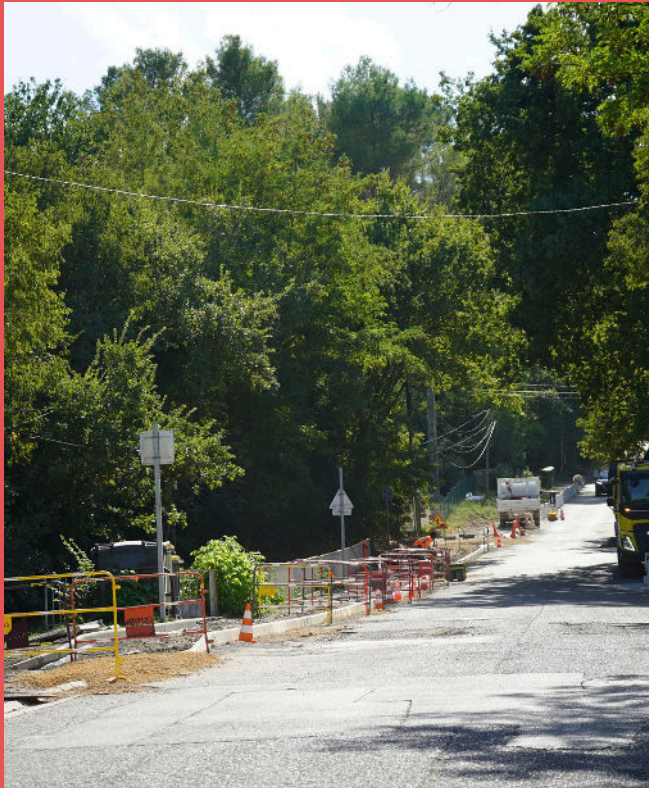
Rue du Pigeonnier et boulevard Kennedy.
