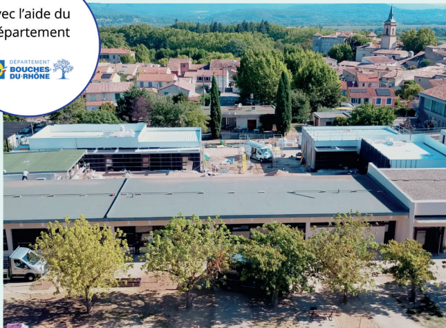
Poursuite des travaux de l'école Paul Claudel
